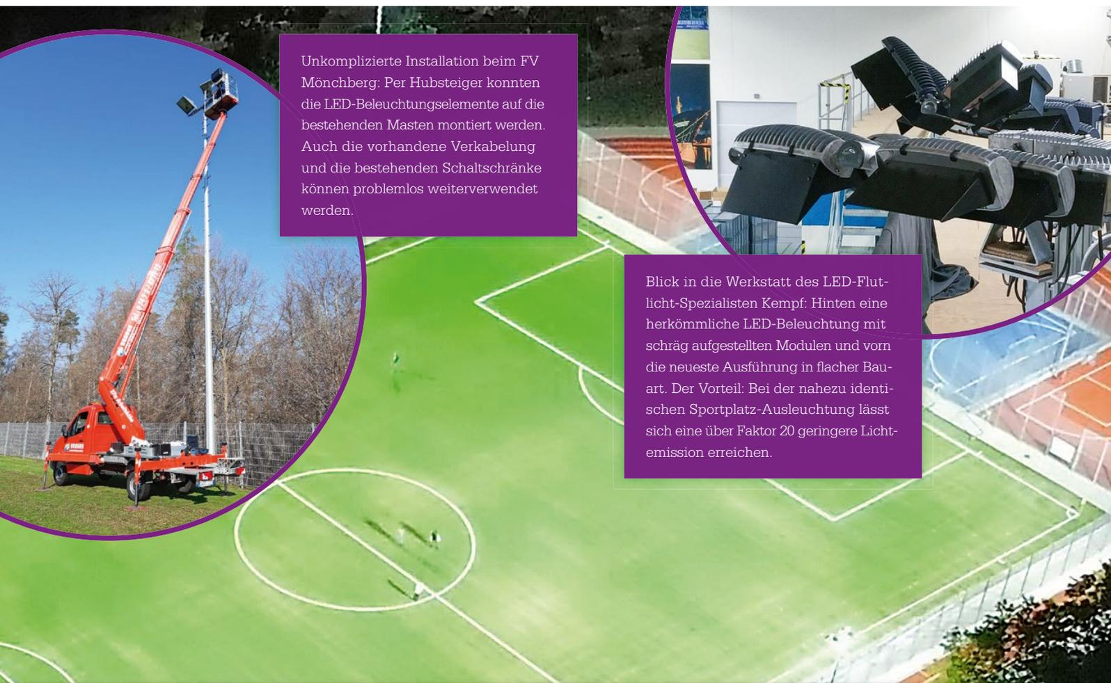
Unkomplizierte Installation beim FV Mönchberg: Per Hubsteiger konnten die LED-Beleuchtungselemente auf die bestehenden Masten montiert werden. Auch die vorhandene Verkabelung und die bestehenden Schaltschränke können problemlos weiterverwendet werden.
